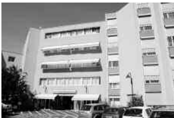
Intégré à l'Hôpital d'Aurillac, le Centre Vignalou héberge des personnes âgées
